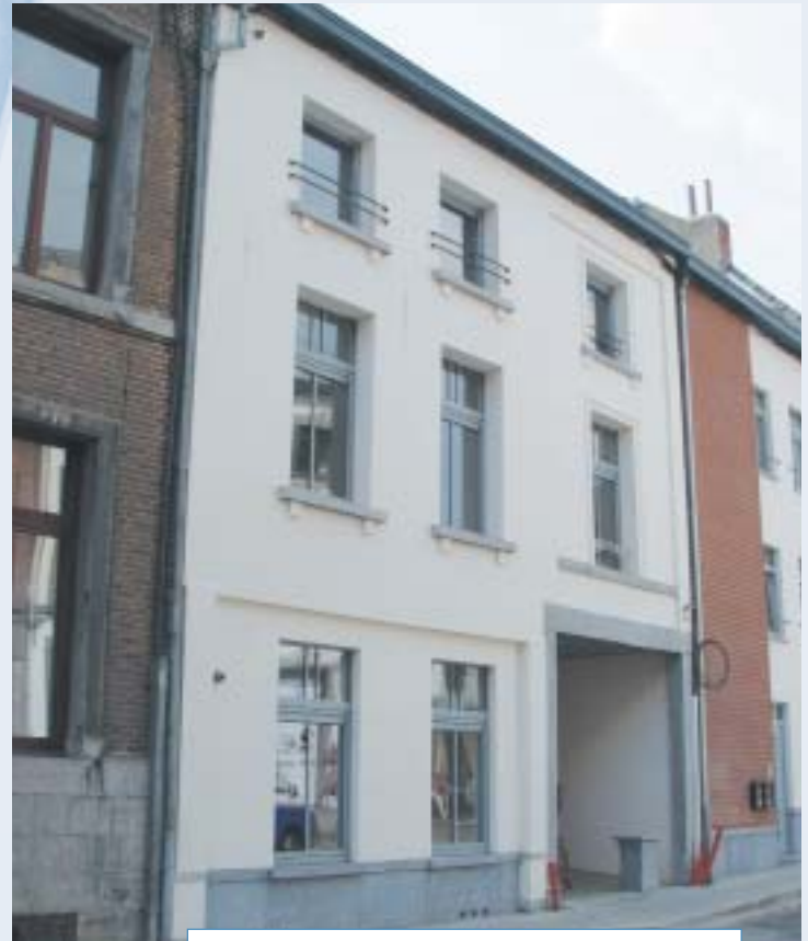
Rue des Récollets : habitation rénovée
