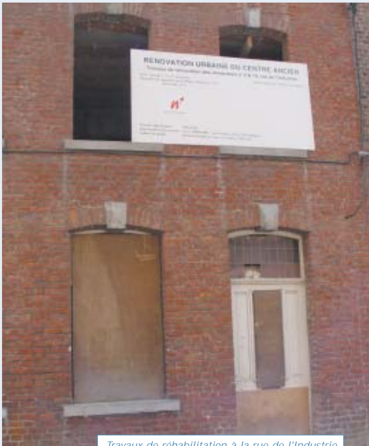
Travaux de réhabilitation à la rue de l'Industrie
