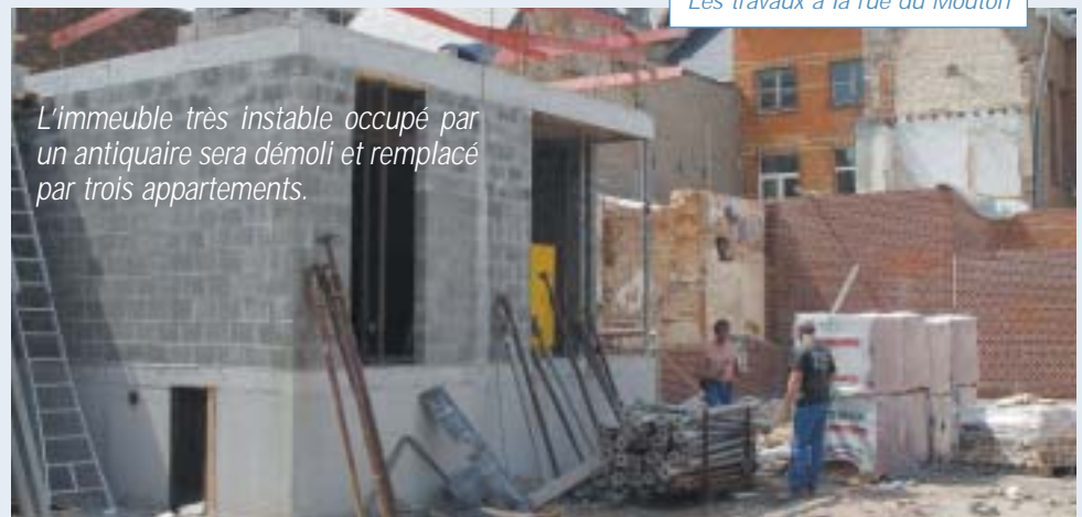
Les travaux à la rue du Mouton
